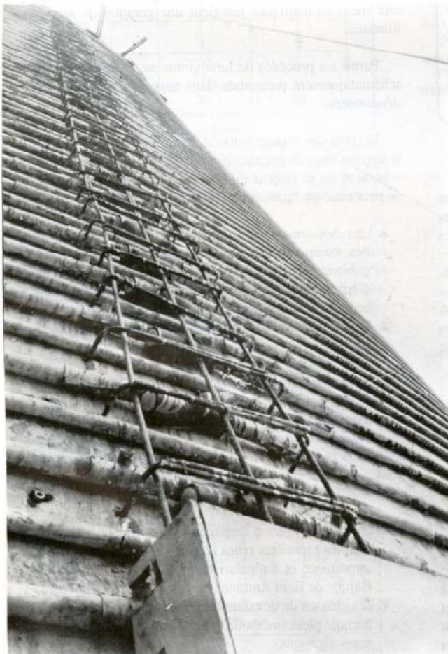
Ancrages en X alignés verticalement.
